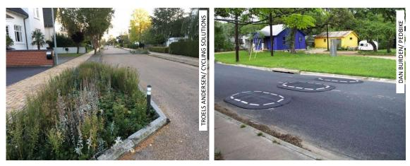
Figura 118: Rua com chicanas na Dinamarca (esq.) e Iombadas com passagem para ciclistas nos Estados Unidos (dir.).
