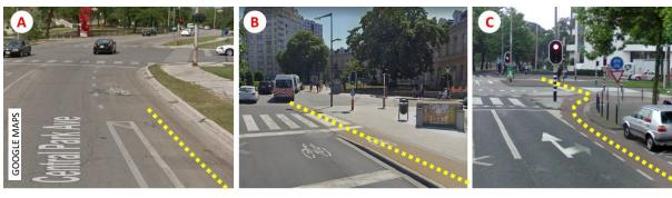
Figura 81: Desvios em interseções (linha amarela). Chicago, Estados Unidos: encurtamento da ciclofaixa pouco antes do cruzamento 🔊, Bruxelas, Bélgica: a ciclovia desce da calçada para o nível da faixa de rolamento 🕏, Roterdã, Holanda: a ciclofaixa é desviada para a calçada e uma ilha separa as bicicletas dos demais veículos 🖒.
