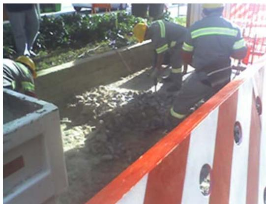
**FOTOS 29 e 30** – Execução das calçadas, por etapas, com canalização para proteger os pedestres. Durante a concretagem/cura das calçadas os pedestres se deslocavam pela faixa de rolamento protegida.
