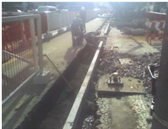
**FOTOS 27 e 28** – Visão da retirada da guia e sarjeta e reposição
